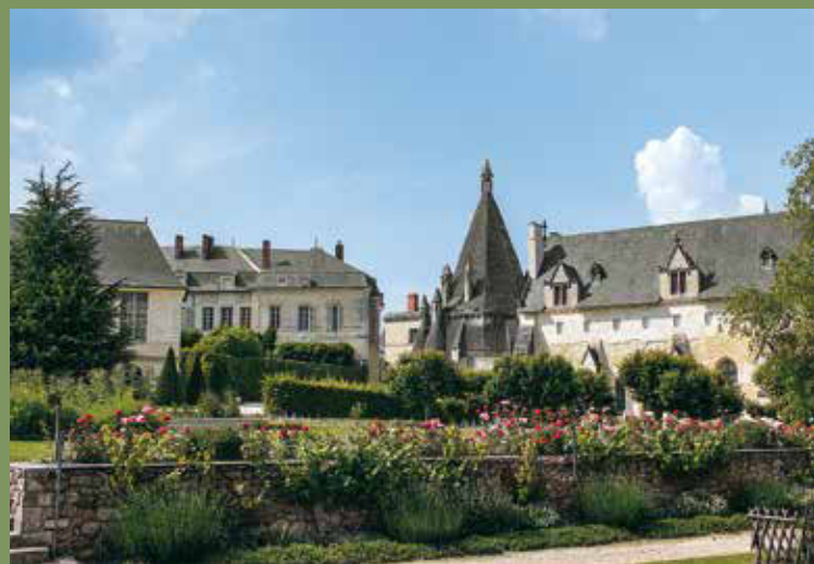
Vue du jardin des abesses à l'abbaye de Fontevraud. On y distingue la toiture des anciennes cuisines et le logis de l'abbesse.
